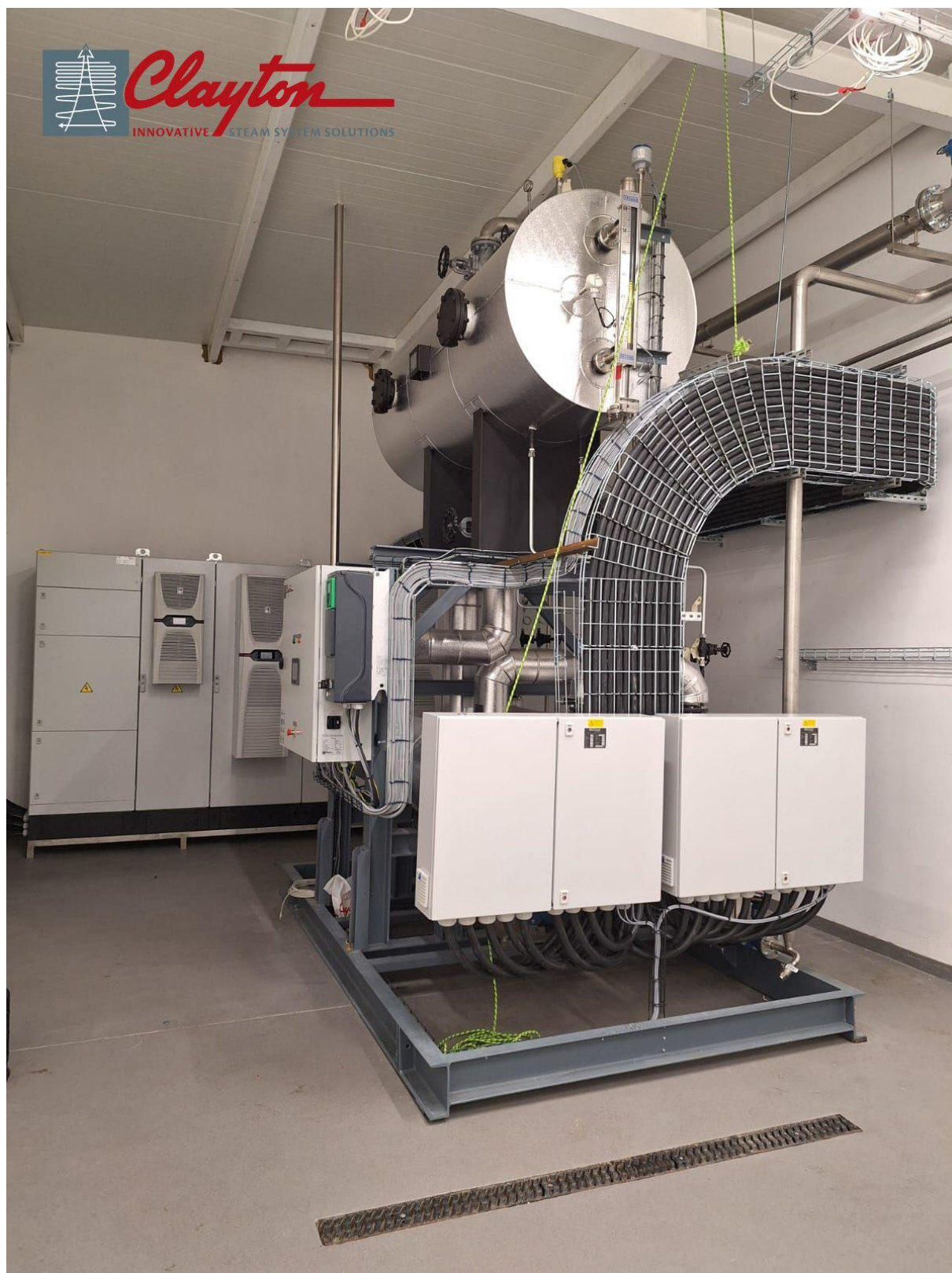
Elektrický parní vyvíječ Clayton řady V150 s výkonem 1,5 MW
